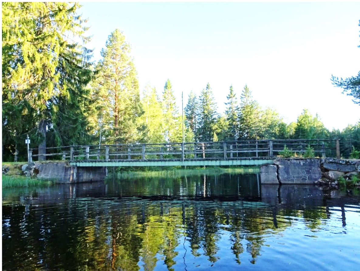
Södra bron. Det spruckna östra landfästet till höger i bild.
