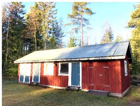
Dusch-, bastu- och förrådsbyggnad
