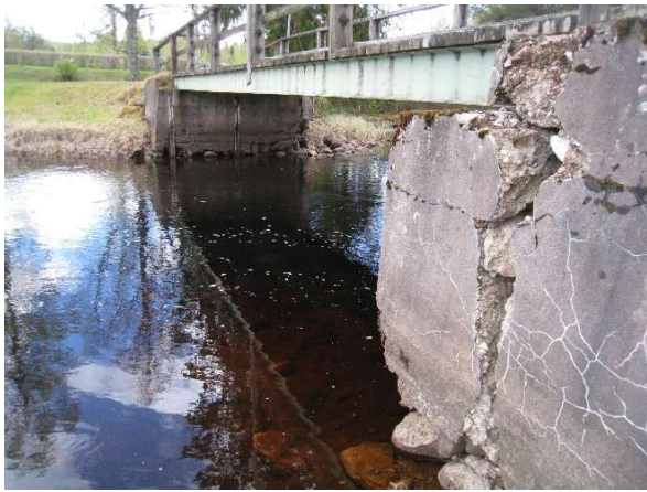
Underminering och mycket kraftig spricka
