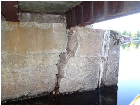
Östra landfästets norra hörn är på väg att falla ut. Balken mister då sitt upplag.
