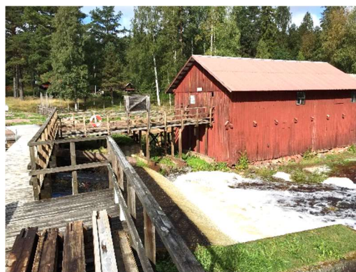
Sågens östra sida sedd från dammen
